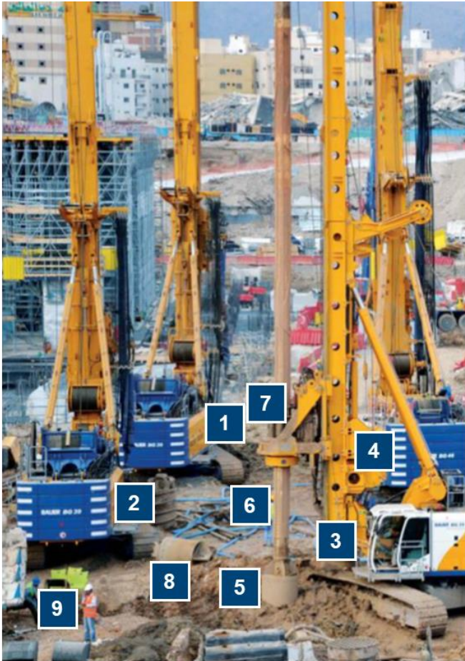
Typische Baustelle Mittlerer Osten
